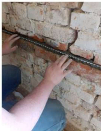
KORAK 3 ojačanje pukotina u zidu armaturnom šipkom
