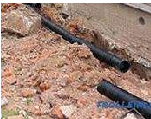
PVC PERFORIRANA CIJEV U TAMPONU ŠLJUNKA
